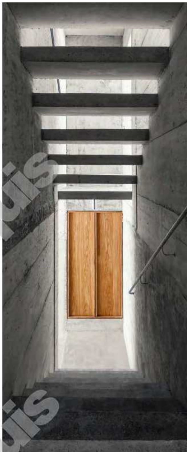
1 Ala Este. Escaleras / East wing. Stairs
